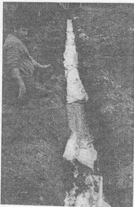
Condotta disperdente al suolo continua in P.V.C. pesante (lunghezza ml. 40)
